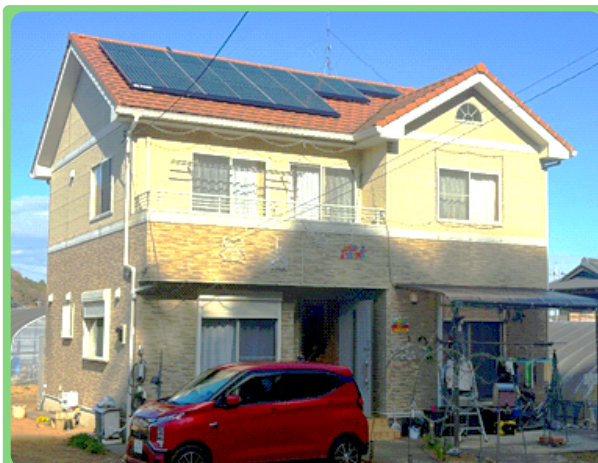
▲屋根置き型太陽光パネルの設置
